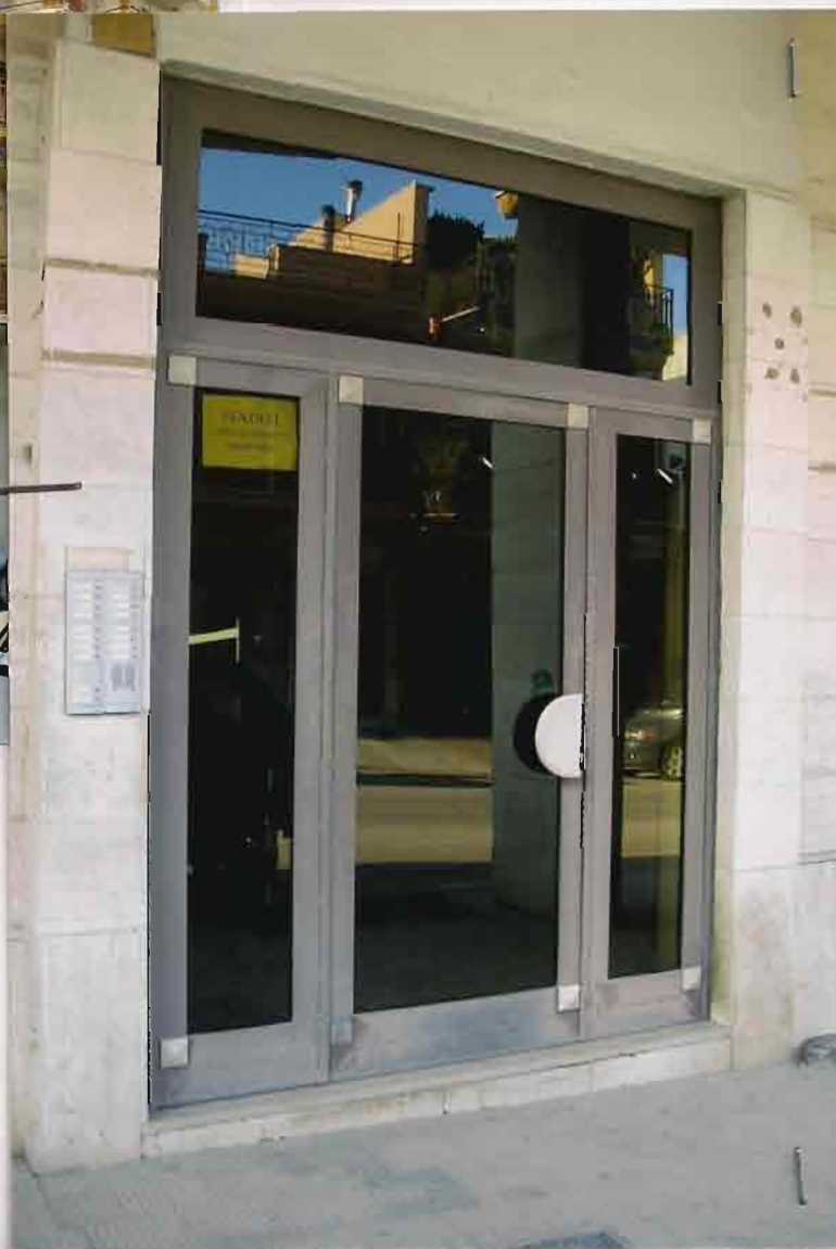
FOTO n° 2 Portoncino ingresso condominiale
